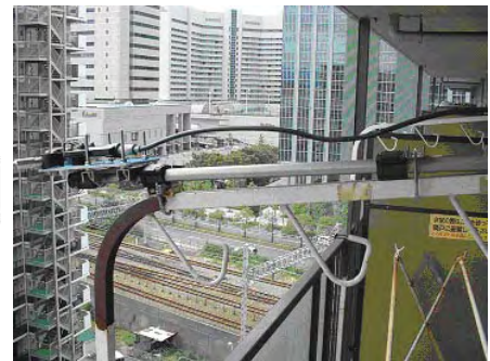
(写真6) 給電点ペランダ手すり柵直上(通常運用時)
