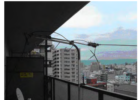
(写真7) 給電点ペランダ外側(40cm伸張、コンテスト時)
