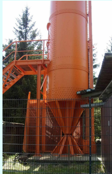
写真12 :アンテナの基部
