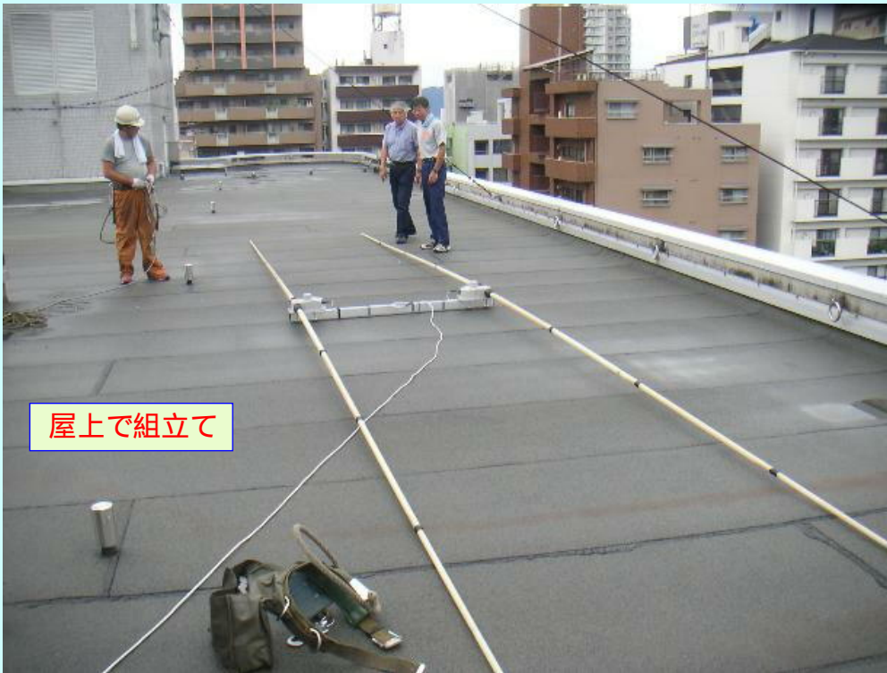
工事前 トライバンダーと6m Yagi
