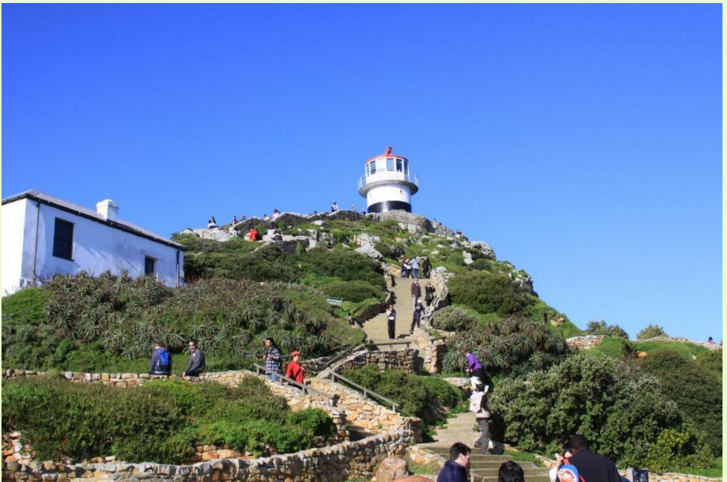
Fig.15 古くなく使われなくなった喜望峰灯台
